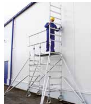
Gesichert durch das „vorlaufende Geländer“ kann die Plattform nun gefahrlos betreten und der weitere Gerüstaufbau fortgesetzt werden. Das Montagesicherungsgeländer wird für folgende Plattformen wieder „vorlaufend“ eingesteckt, ehe die nächste Ebene betreten wird.
